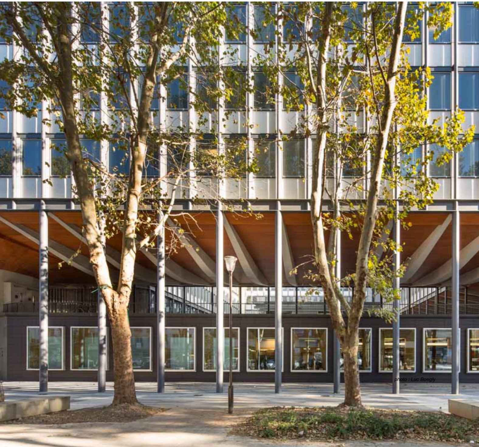
1- LA BIBLIOTHÈQUE OUVERT VERS LA RUE DES FOSSÉS SAINT BERNARD
