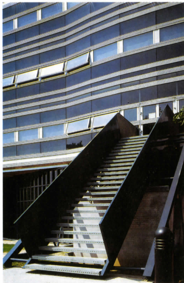
Escalier d'accès au niveau principal.
