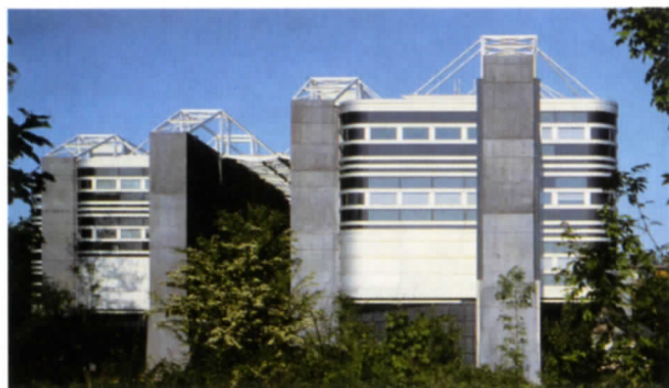
Vue du pignon est.
